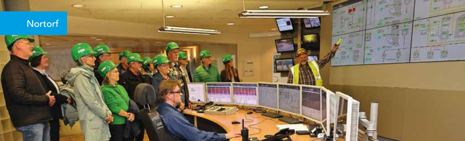
Jan Emsmann (rechts) erklärt der Besuchergruppe den Arbeitsplatz des Leitstandsfahrers, von hier aus wird das gesamte Kraftwerk gesteuert.
